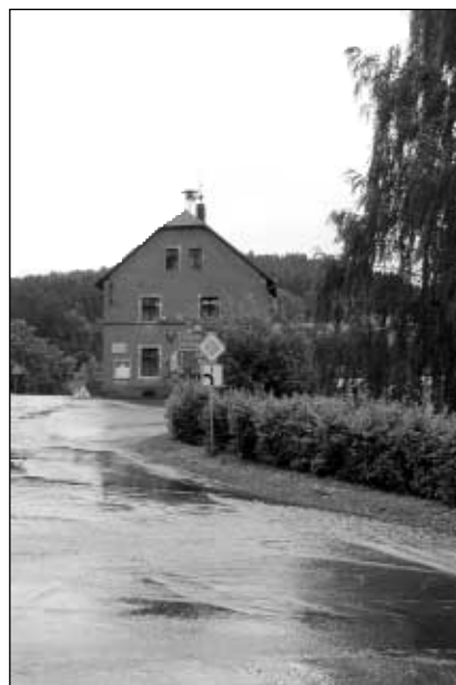
Voda ničí veřejné i soukromé komunikace.
